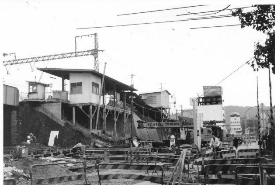
油阪駅西から東方向 地下化工事中(昭和43年)
